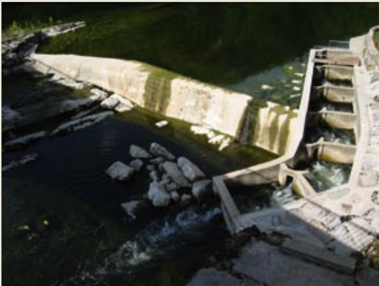
Des passes à poissons permettent aux truites, par exemple, de remonter le courant pour frayer.
