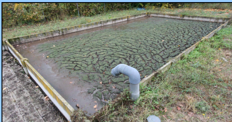
Figure 5 – Lit de séchage (Sce : Parc du Verdon)
