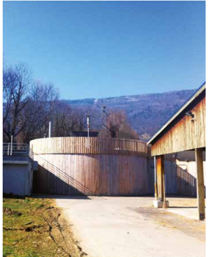
Unité de méthanisation au lycée agricole de la Motte Servolex (73)
