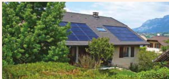
Modules BISOL monocrystallins intégrés au bâti
