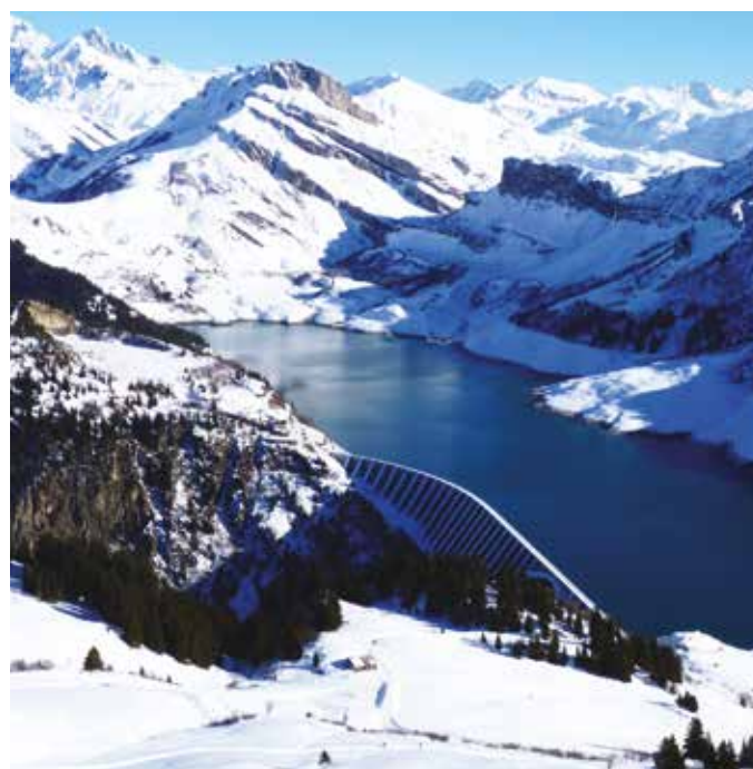
Barrage de Roselend en 2007 - Beaufort-sur-Doron (73) © EDF UP Alpes - droits réservés
