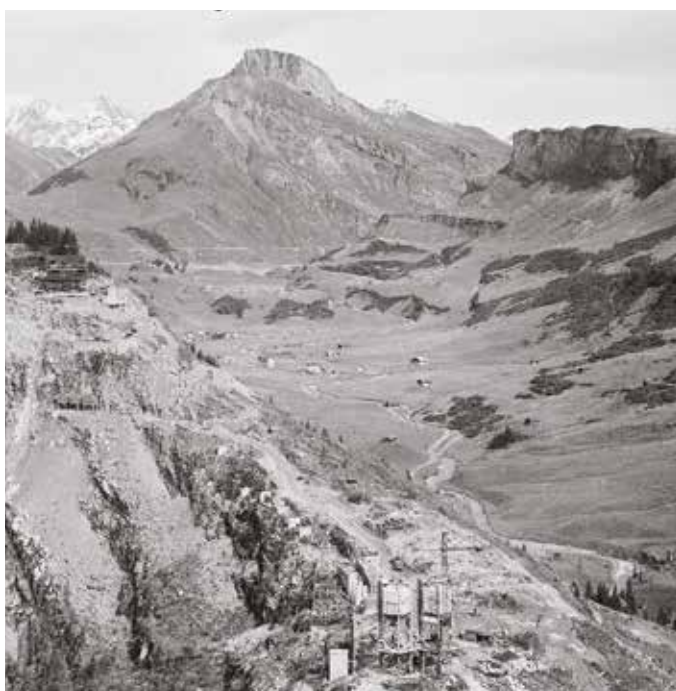
Construction du barrage de Roselend en 1955 - Beaufort-sur-Doron (73) © EDF - Collection Henri Baranger
