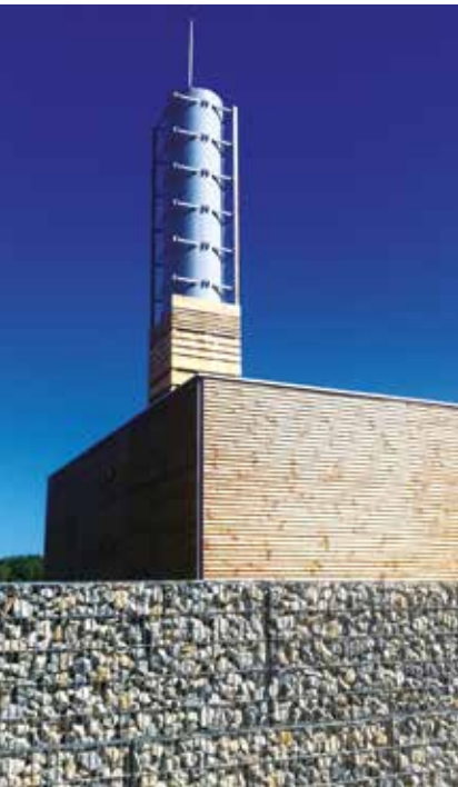
Chaufferie bois de Viry (74) - Chaleur des Alpes
