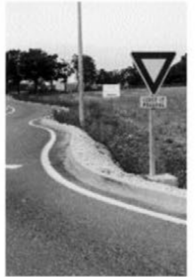
Les accotements à peine terminés
