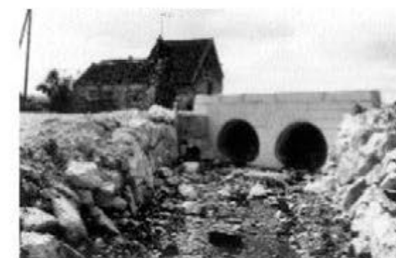
Vue du pont en aval
