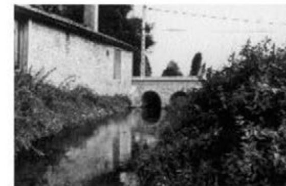
Vue du pont en amont
