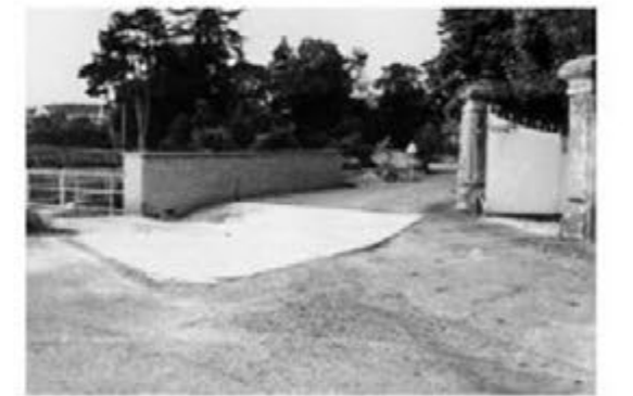
Bac de décantation
