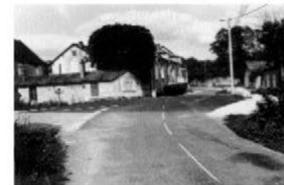
La chaussée du pont élargie
