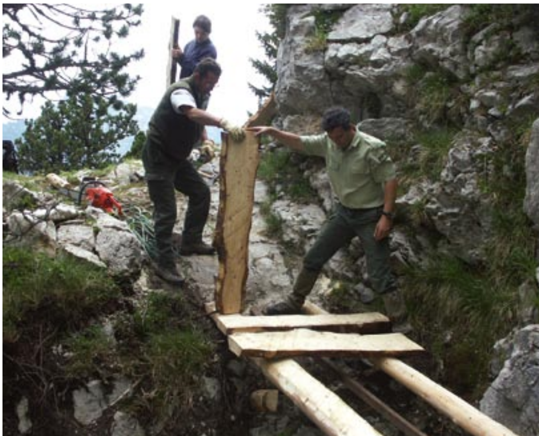
Isère. Réalisation d'une passerelle par les employés de l'ONF, partenaire du comité de la randonnée pédestre.
