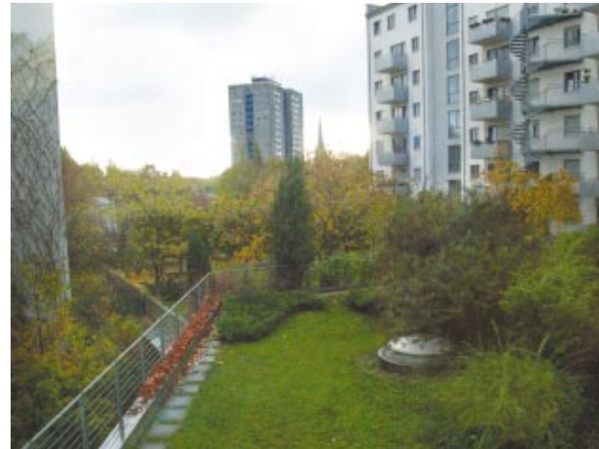
> Les toitures-terrasses végétalisées permettent non seulement de retarder les rejets des eaux pluviales dans les réseaux mais aussi de recréer en milieu urbain des espaces verts favorisant la biodiversité et d'améliorer les confort estival en réduisant les apports solaires à travers les toitures.
