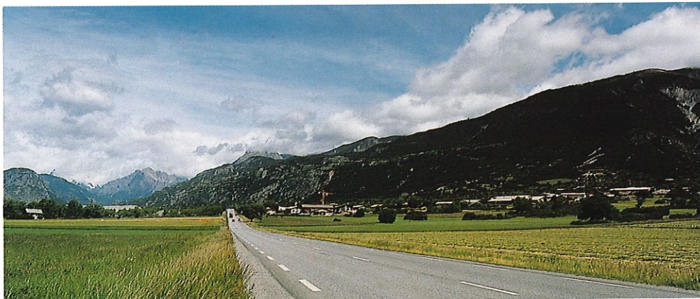
Profil longitudinal du cône de déjection du Merdanel sur lequel s'est développée la zone artisanale de St-Crépin
