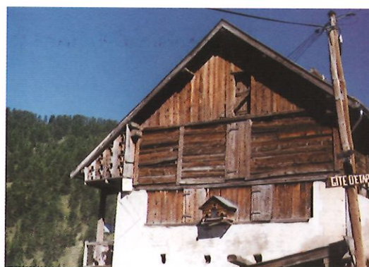
Grange en bardage de bois - présence d'un pigeonnier
