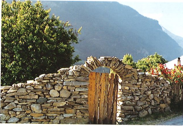
Muret de pierres sèches à St-Clément
