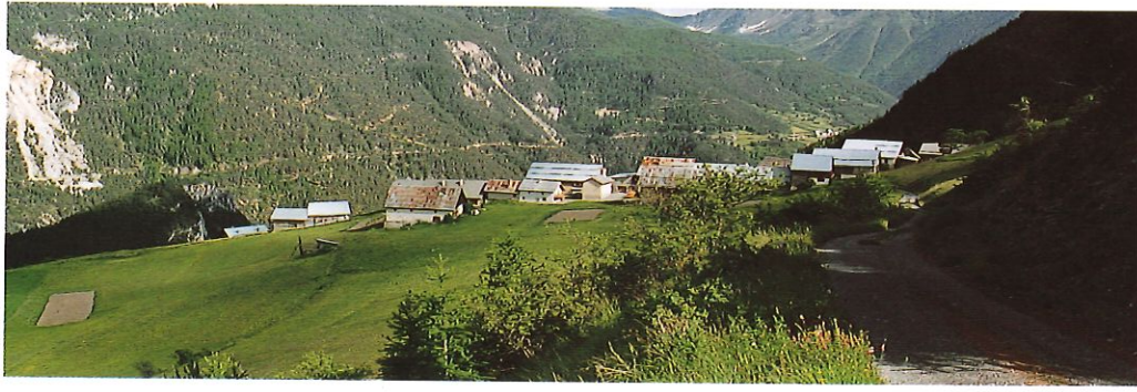
Absence de zone de transition entre prairies et constructions. Les bâtiments semblent «posés» sur la prairie
