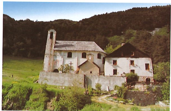
Eglise et presbytère des Veyers
