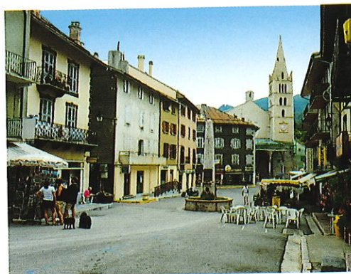
Architecture urbaine à Guillestre
