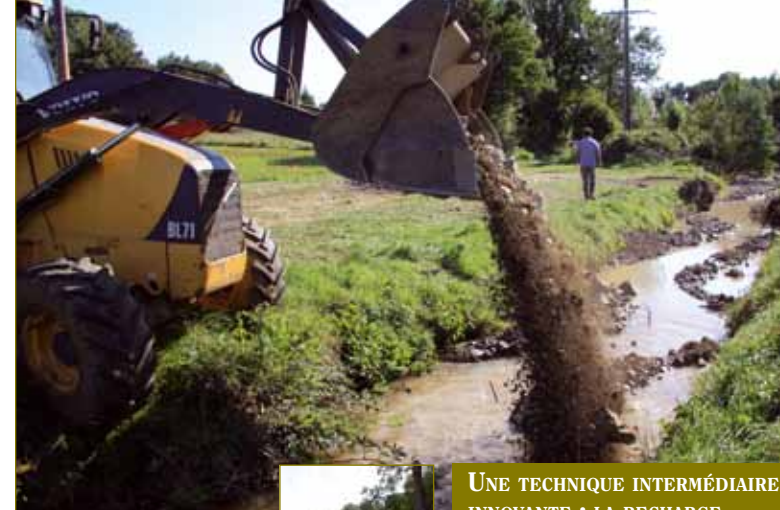
Déversement de granulats sur le Marolles en 2008 (79) © Michel Bramard
