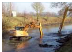
Travaux sur l'Authion (49) © Vincent Molinier
