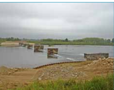
Déconstruction du barrage de Blois, octobre 2009 (41) © Romain Suaudeau
