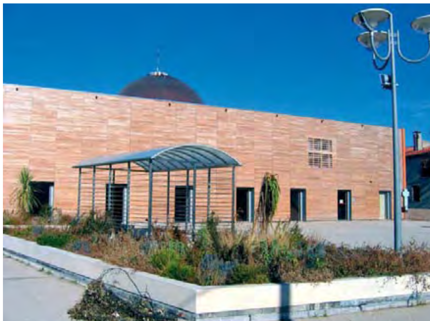
Bardage en robinier couvrant les murs de l'église de la Sainte Famille à Istres (13)
