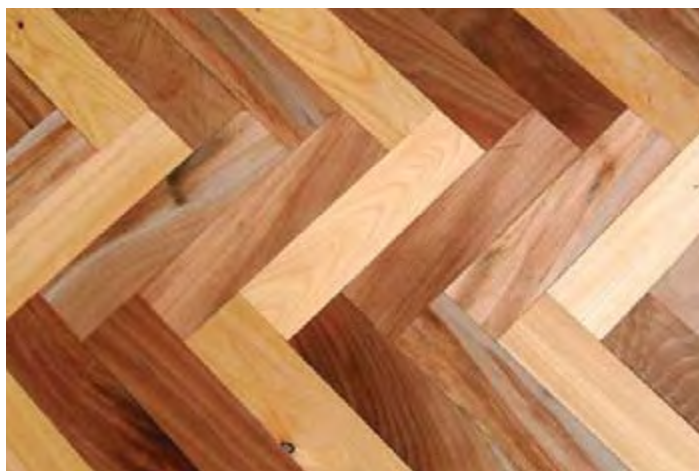
Echantillon de parquet en bâton rompu en lames massives de cyprès méditerranéen et platane B. Barascut (34)
