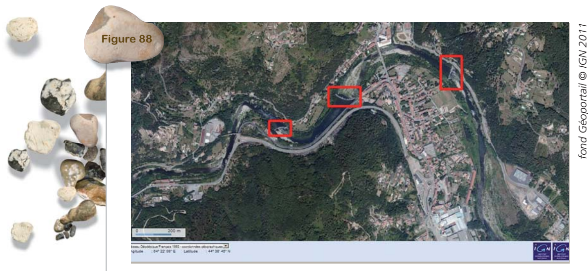
Succession de seuils sur l'Ardèche. En raison de la forte puissance du cours d'eau il ne semble pas y avoir de piégeage majeur en amont des ouvrages.
