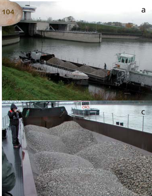
Transfert des alluvions extraites en lit majeur (a et b) et « clapping » (c) sur les tronçons identifiés comme déficitaire par bathymétrie en temps réel (d) sur le Rhin en aval du barrage d'Iffensheim.
