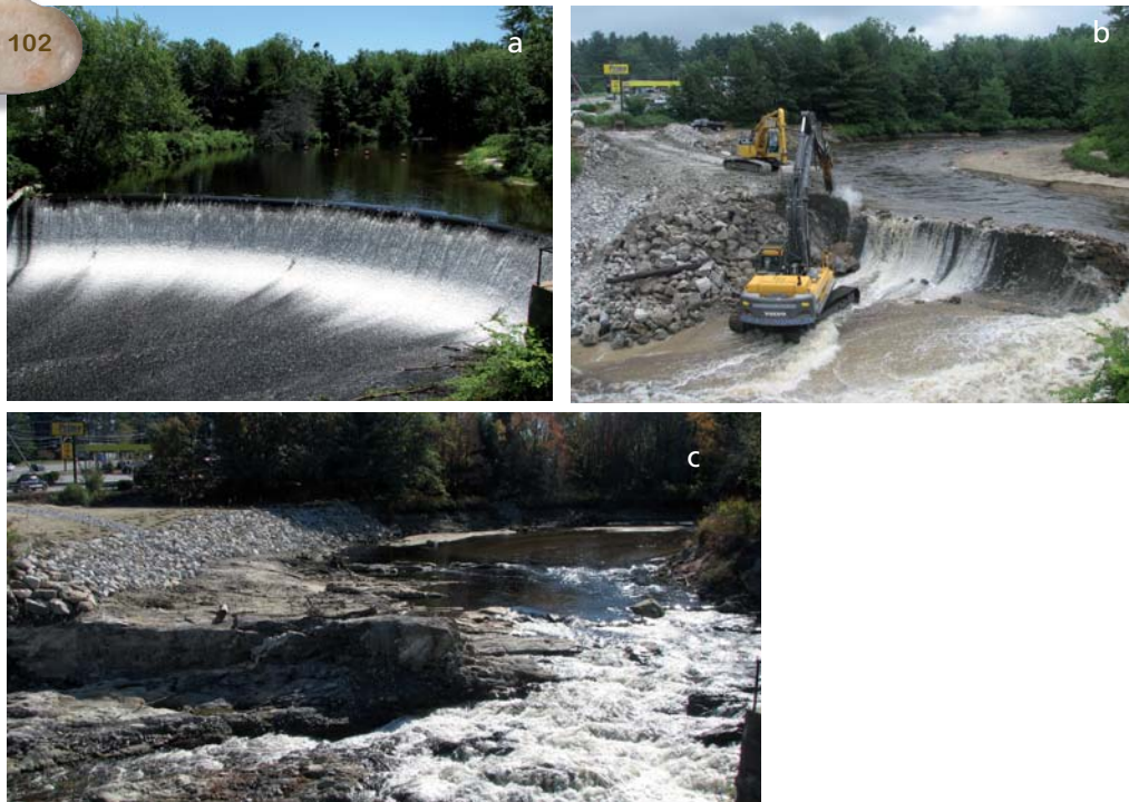
Exemple de dérusement d'un ouvrage. Noter la disparition du banc de convexité présent dans l'ancienne retenue à droite sur la photo.
