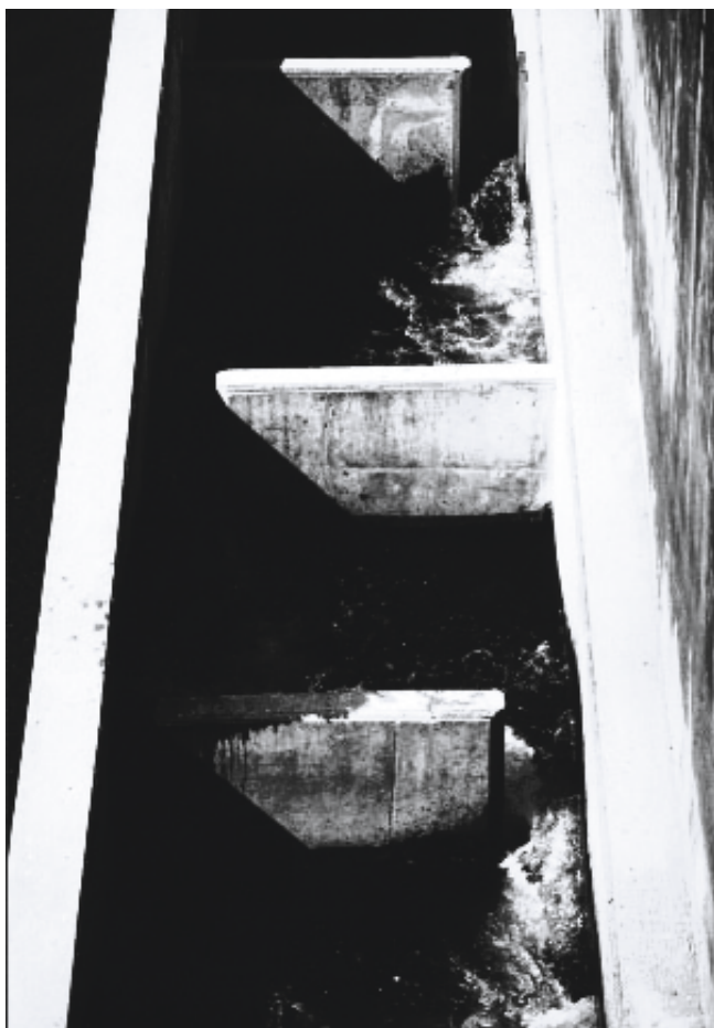
Photo 3.2 : Passe à poissons à bassins successifs
