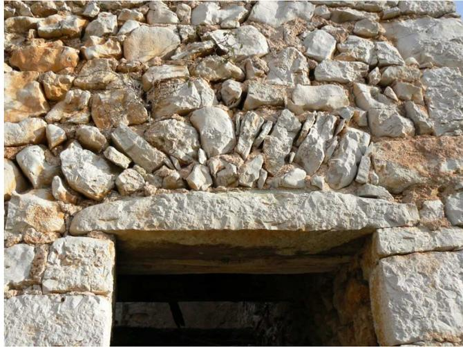
Grand Plan. Détail d'une ouverture : arc de décharge voûté au-dessus du linteau.
