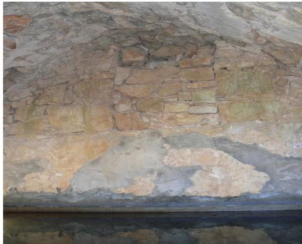
Grand Plan. Intérieur d'une citerne jouxtant une habitation. Encavée en partie, munie d'une petite porte, la voûte de son toit supporte une large dalle plate. La partie intérieure est carrelée au niveau de la hauteur d'eau.
