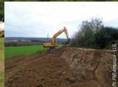
Travaux de création de talus sur la commune de Pont-de-Buis-lès-Quimerç'h.
