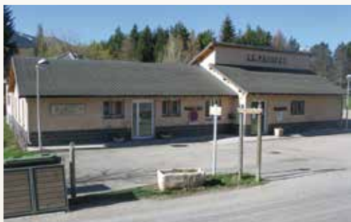
La crèche de La Cabanasse a été mise aux normes énergétiques.
