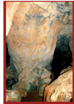
Photo3 : Flambage d'un pilier - Shearing and breaking pillar (Cave N')
