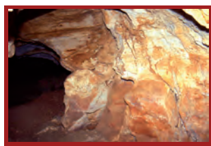
Photo7 : Piédroits éclatés et cisailés. Galerie "fossile" vidée de son remplissage sous une falaise décomprimée - Sismic features at the wall-gallery with shearing and break into a karstic upper network at the basement of uncompressed cliff. Erosion unfilling gallery.
